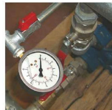
Fig. 5: Sustitución del manómetro en bomba
